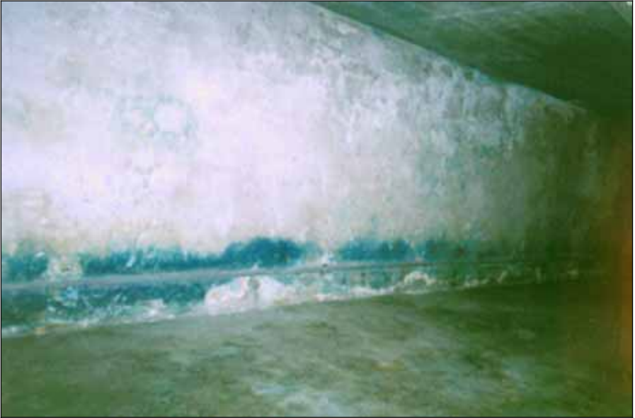
Fotografie XIII: Entwesungsanlage bei der Baracke 41, Kammer III, Ostwand. (© C. Mattogno.)
