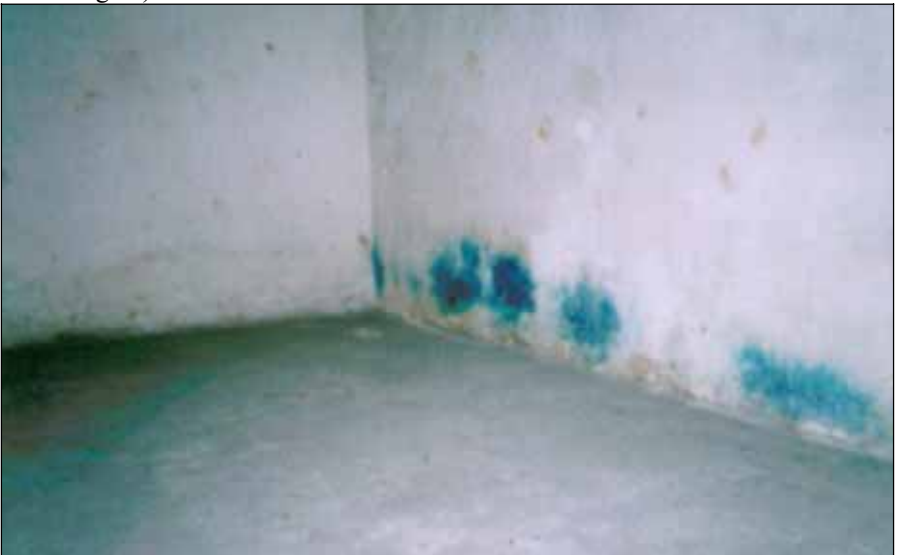
Fotografie XIV: Entwesungsanlage bei der Baracke 41, Kammer II, Westwand. (© C. Mattogno.)
